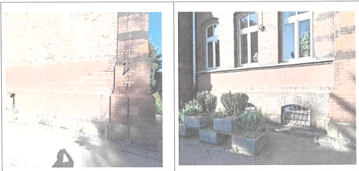
Fot.2 Dolne części elewacji. Ubytki korozyjne w cegle elewacyjnej. Okładzina klinkierowa zamalowana do wysokości parapetów okien parteru
