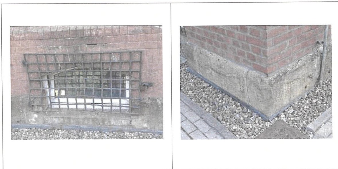
Fot.5 Dolne obszary elewacji. Widoczne braki spoinowania okładziny klinkierowej, uszkodzenia i korozja stalowych krat okiennych oraz ubytki części kamiennej cokołu.
