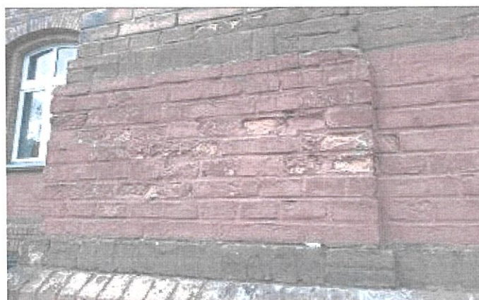
Fot.3 Uszkodzenia (ubytki) cegły ceramicznej, ubytki spoinowania
