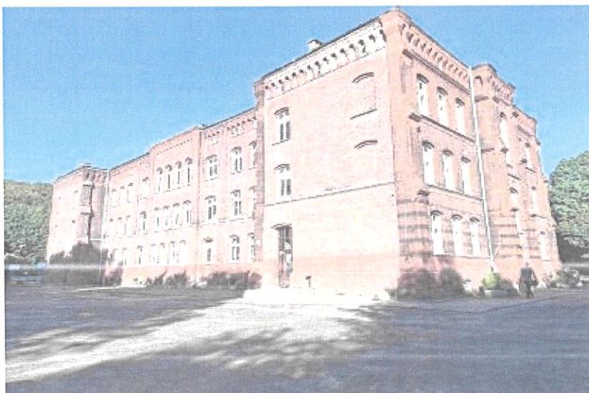
Fot.1 Widok ogólny. Elewacja wejściowa wykonana z kształtek ceramicznych w układzie główkowym. Elewacja boczna wykonana z cegły ceramicznej półklinkierowej. Widoczne zamalowana farbą olejną do wysokości parapetów okien parteru.
